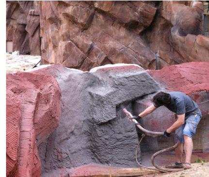
Utiliser le mortier de moulage à projeter à une température supérieure à 5°C et inférieure à 35°C. Ne pas utiliser sur un support gelé.
