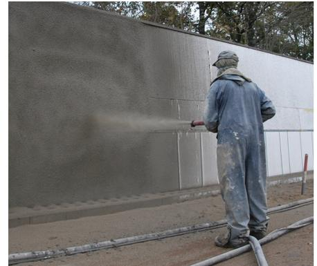
minimum à la résistance d'adhérence requise du béton de gunitage. S'il existe un doute en ce que cela concerne, il faut, préalablement à l'application, réaliser une analyse de la résistance d'adhérence.
